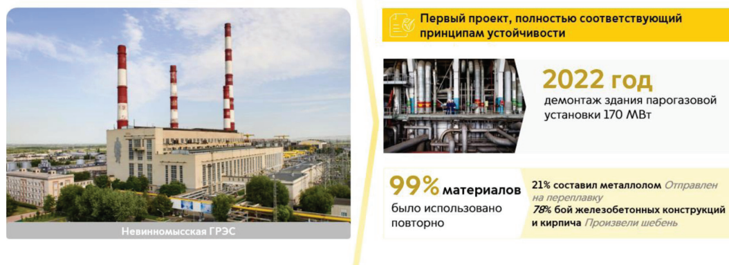
Рис. 4. Детали проекта по демонтажу здания парогазовой установки на Невинномысской ГРЭС Источник: составлено авторами на основе [11;12]
